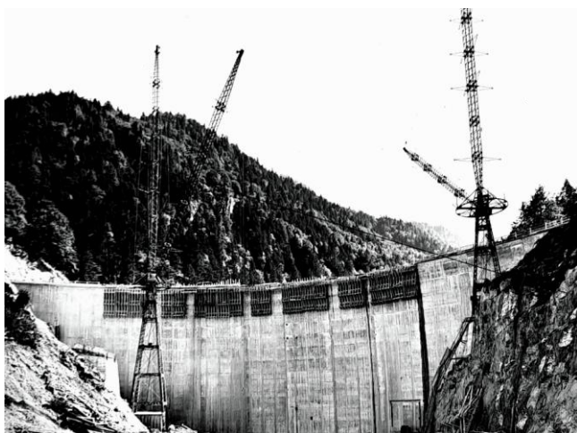
Le fasi finali della costruzione della diga della Roggiasca in una foto del 17 settembre 1964.
